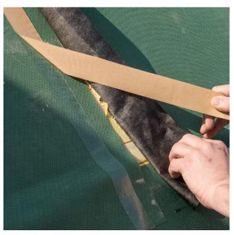
Im Gegensatz zur Zwischensparrendämmung wird eine vollständig homogene Dämmdicke über die gesamte Dachfläche erreicht. Weiterer Vorteil: die Tragkonstruktion des Dachstuhles bleibt sichtbar. Gute Schallschutzwerte bei einer Auflegung einer 40 mm dicken Sichtschalung mit Doppelnut.
