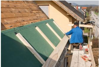
Es empfiehlt sich die Verschraubung der Konterlattung mit ø 8 mm Zylinder Vollgewinde-Schrauben vorzunehmen.
