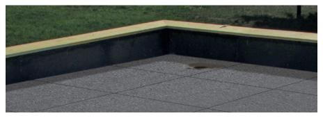
Flachdächer sind mit einem Gefälle auszuführen. Dieses kann entweder durch die Unterkonstruktion (Decke-Gefällebeton) oder mittels Austrotherm EPS® W30-PLUS Gefälledach über der Austrotherm Resolution® Flachdachdämmplatte ausgeführt werden.
