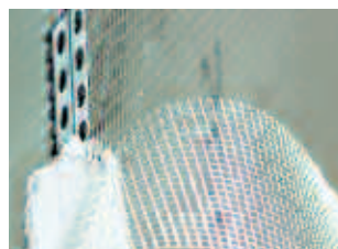
Mit Glasseiden-Gewebestreifen schließen sich Plattenstöße.
