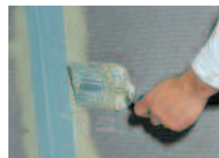
Zuletzt Dichtband einlegen, einfach mit Wandglätter verspachteln – fertig ist der glatte Untergrund!
