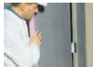
Schon fügt sich eine Austrotherm UNIPLATTE® an die andere.
