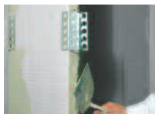
Auch die Murexin Verbindungs-klammer ist rasch montiert.
