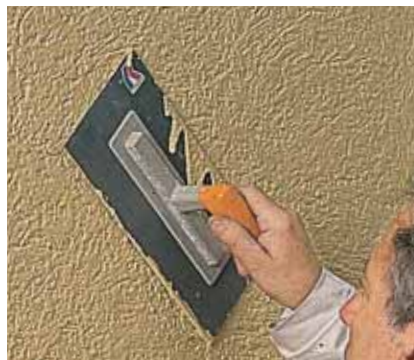
Dünnputz (z.B. Baunit SilikonPutz, Baunit SilikatPutz) auftragen und strukturieren.
