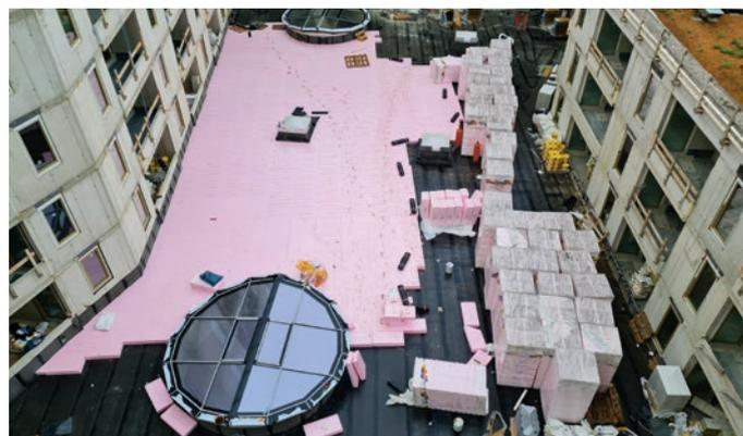
Das Dach der Shopzone wurde mit dem druckfesten Austrotherm XPS® PLUS bestens gedämmt und fungiert als begrünter Innenhof.
