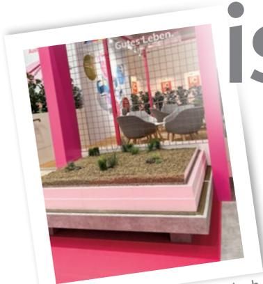
Aufbau Austrotherm Umkehrdach am Messestand
