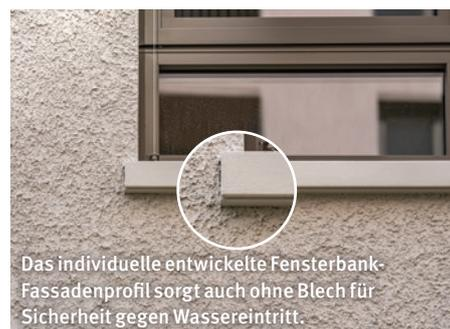
Das individuelle entwickelte Fensterbank-Fassadenprofil sorgt auch ohne Blech für Sicherheit gegen Wassereintritt.
