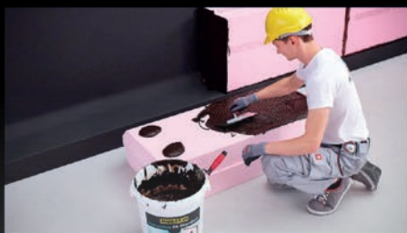
Austrotherm XPS als Perimeterdämmung bei Grundwasser
