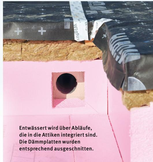
Entwässert wird über Abläufe, die in die Attiken integriert sind. Die Dämmplatten wurden entsprechend ausgeschnitten.
