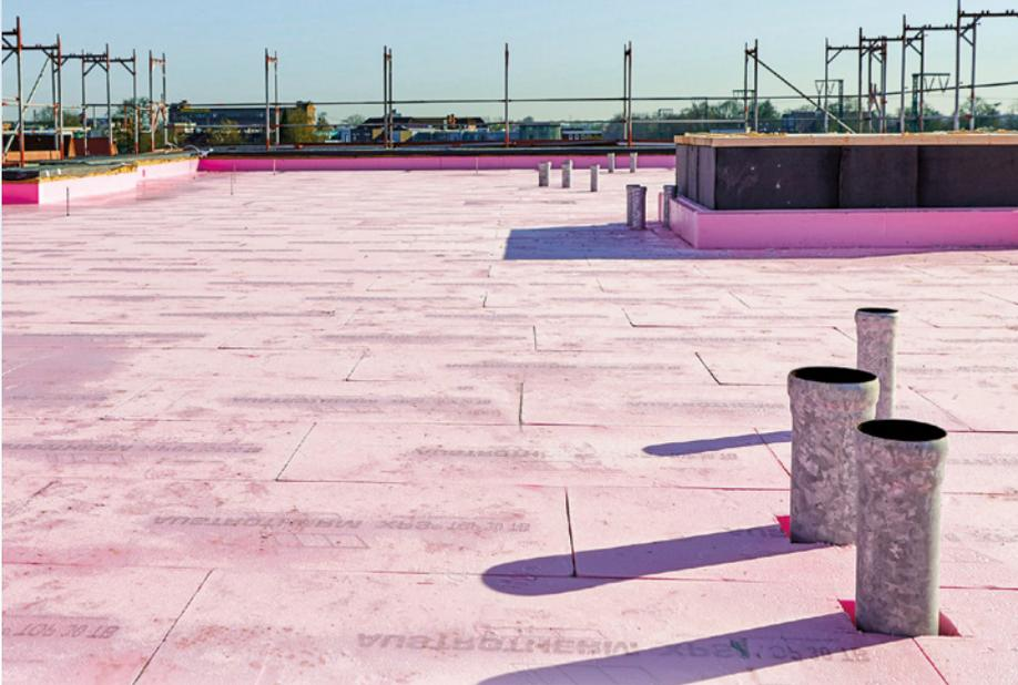
Flüssigkunststoff dichtet die Fugen des WU-Betons.
