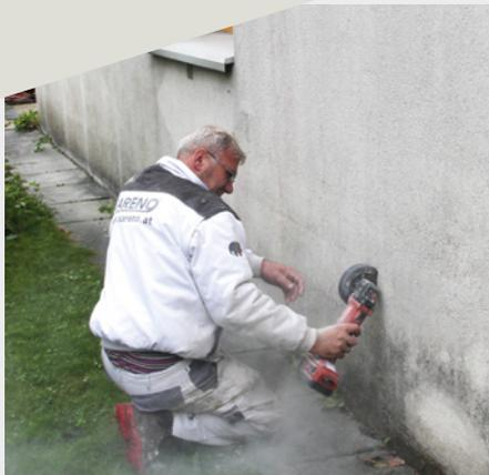
Beim „Strippen“ der Fassade wird der Putz eingeschnitten.
