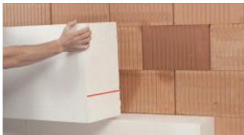
Fassadendämmpfplatte aus expandiertem Polystyrolhartschaumstoff
