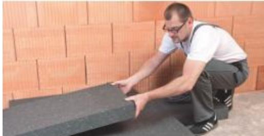
Druckbelastbare höchstwärmedämmende Dämmplatte aus expandiertem Polystyrolhartschaumstoff
