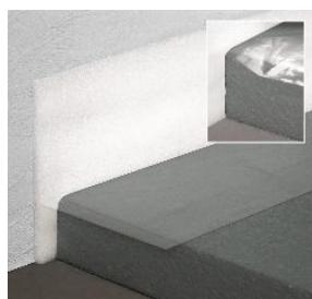
Trennlage zwischen Mauerwerk und Estrich zur Vermeidung von Schallübertragungen
