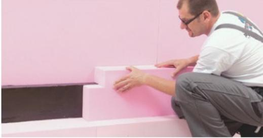
Druckfeste Wärmedämmplatte aus extrudiertem Polystyrolhartschaum mit **Gerader Kante (GK)**
