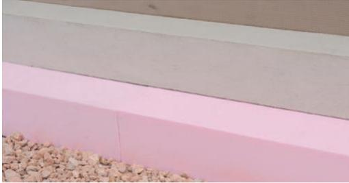
Wärmedämmplatte aus extrudiertem Polystyrolhartschaum für höchste Druckbelastungen mit Stufenfalz (SF)
