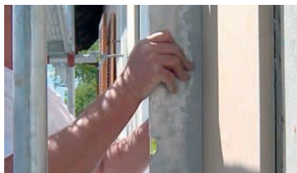
Das Austrotherm Designelement kann einfach ohne spezielles Werkzeug vertikal ausgerichtet werden.
