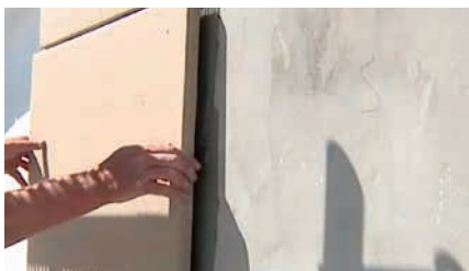
Behutsam wird die Einrichtung der Elemente an der Wand durchgeführt.
