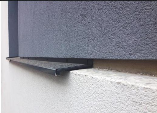
Das Sohlbankblech wird an der integrierten Montageleiste des Sohlbankanschlussprofils verschraubt. Dadurch ist es jederzeit leicht wieder zu entfernen.
