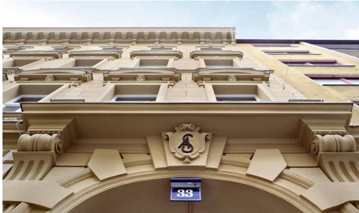
Bildtext zu Foto Austrotherm_Fassadensanierung_Premium_02.jpg: Fassadensanierung auf höchstem Niveau. In der Graf-Starhemberg-Gasse im 4. Wiener Gemeindebezirk kam die Austrotherm Fassadensanierung Premium zur Anwendung und setzt mit dieser Innovation Impulse für eine nachhaltige Stadtentwicklung. Fotocredit: Austrotherm, honorarfrei.
