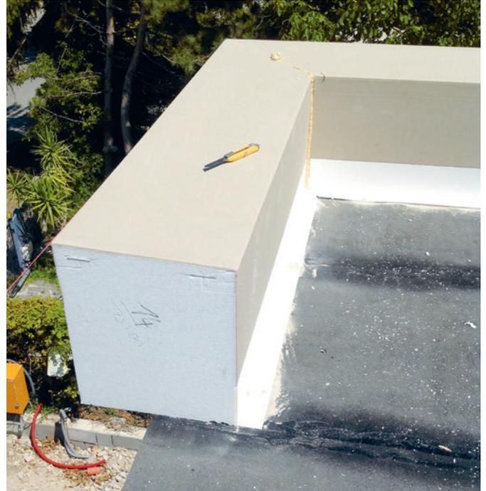
Das Austrotherm Attikaelement ist die neue kostengünstige Alternative zur herkömmlichen Attika Bauweise. Wo bisher teure Betonschalungen und zusätzliche Dämmelemente notwendig waren, kann nun das neue Fertigteilelement eingesetzt und dadurch kräftig gespart werden.
