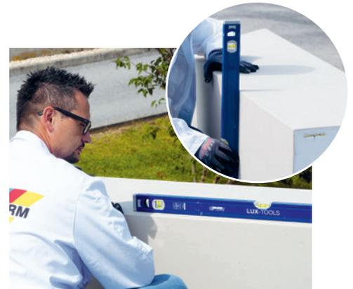
5. Das Einrichten erfolgt per Wasserwaage.
