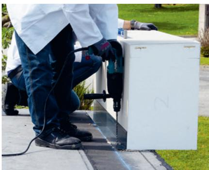
6. Die mechanische Befestigung erfolgt durch den PVC-Winkel in den vorhandenen Untergrund.
