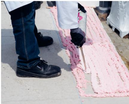
4. Austrotherm Attikaelemente dürfen nur auf stabile, staub- und fettfreie Untergründe geklebt werden. Der dafür verwendete Kleber wird auf die Elemente und den Untergrund der zu klebenden Flächen aufgetragen. Beachten Sie bitte die Verarbeitungsrichtlinien des Klebers.
