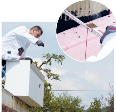
2. Der Abstand wird mit Hilfe eines Ankerlots eingerichtet.
