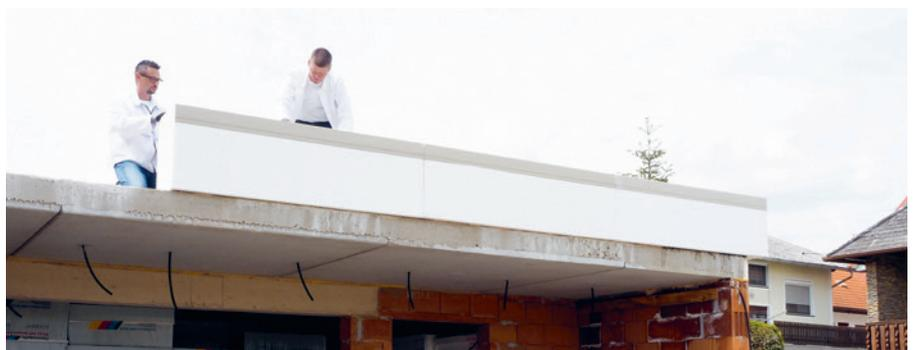
7. Die Austrotherm Attikaelemente sind in den jeweiligen Breiten ab 300 bis 500 mm bzw. in den verschiedenen Höhen ab 400 bis 700 mm erhältlich. Die Länge beträgt 2000 mm.
