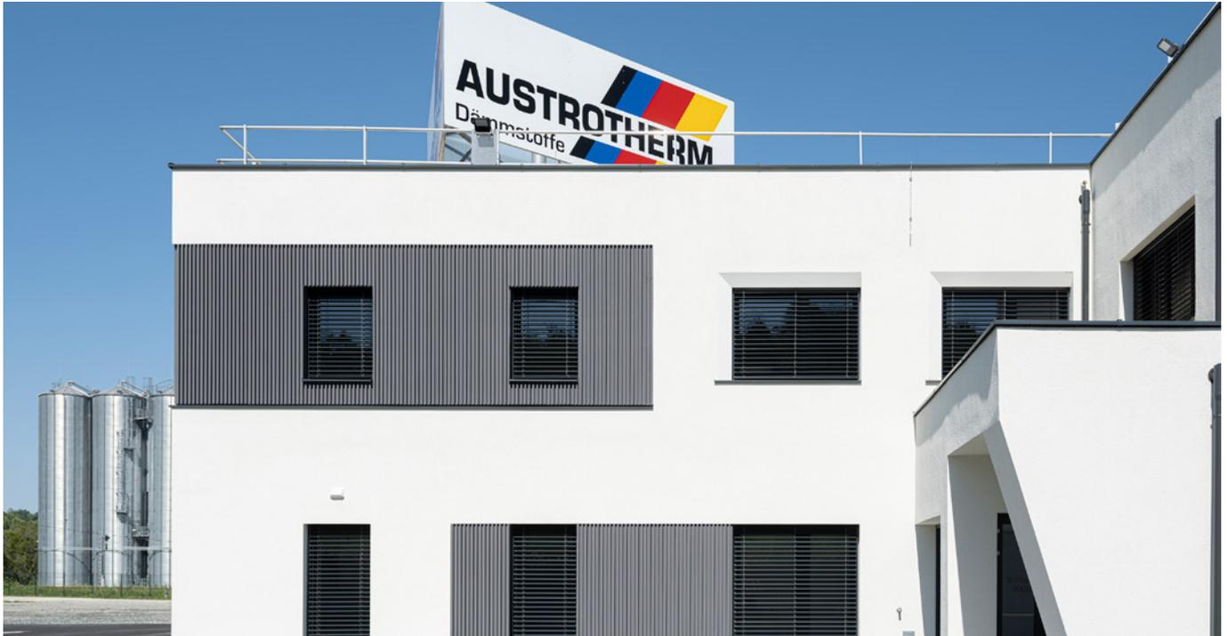
Das Austrotherm Attikaelement ist die neue kostengünstige Alternative zur herkömmlichen Attika Bauweise. Wo bisher teure Betonschalungen und zusätzliche Dämmelemente notwendig waren, kann nun das neue Fertigteilelement eingesetzt und dadurch kräftig gespart werden.
