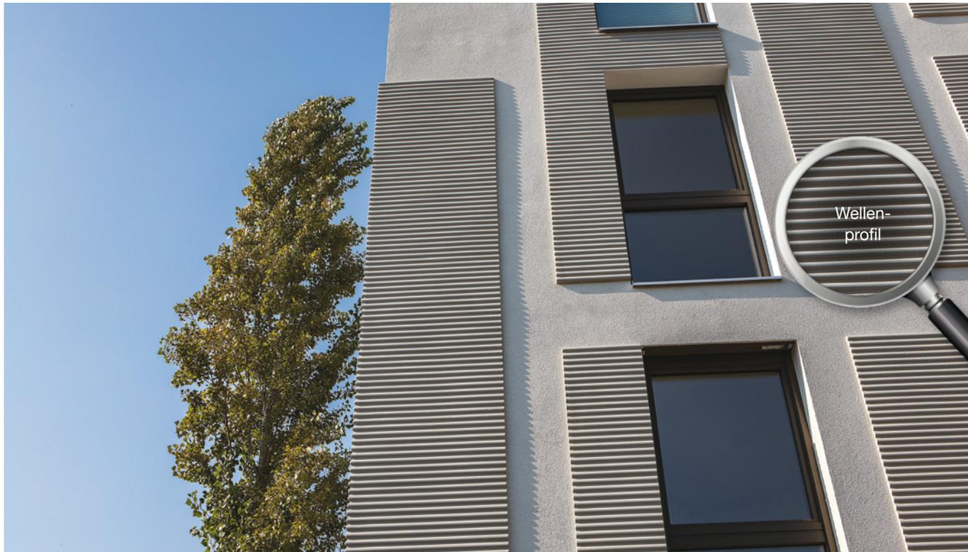
Eine Variante ist es, die gesamte Fassade mit Wellenelementen zu überkleiden; alternativ setzt man Akzente durch gestaltete Teilflächen, zum Beispiel in Kombination mit glattem Putz.
