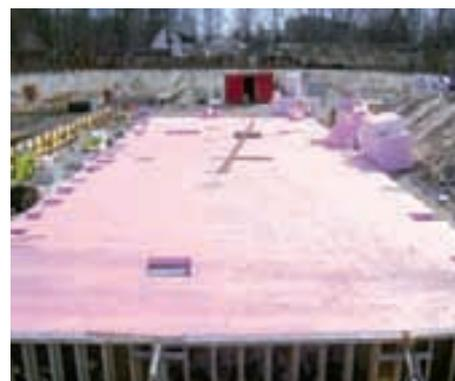
Die neuartige Austrotherm XPS®-Spezialanwendung, mit mehrlagig gefertigten Hülsen für eine wärmebrückenfreie Dämmung der Pfahlgründungen
